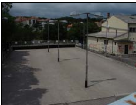
SLIKA 20. Pogled na bočalište - lokacija crkve
